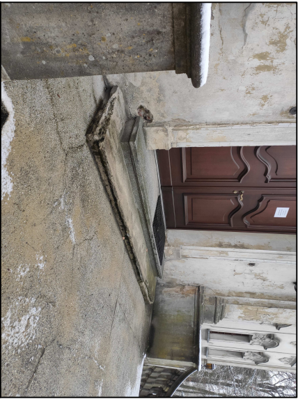
D Schody główne - naprawa spękań, replifikacja stopni, wykonanie wycieraczki oraz odwodnienia
