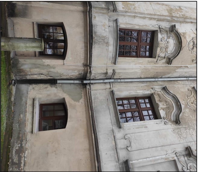
C Spękania tynku
