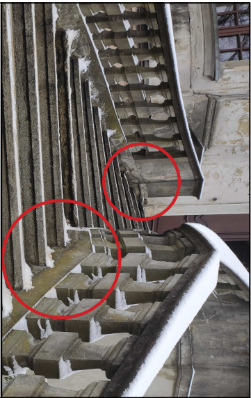
A Schody główne - naprawa spękań, replifikacja stopni i spoczników
