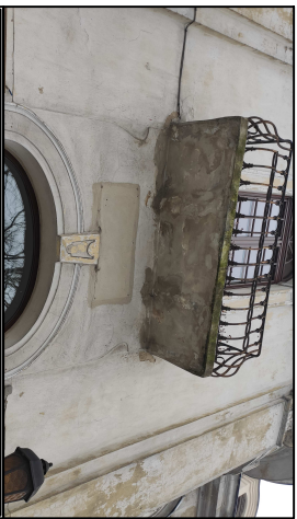
G Balustrady -demontaż na czas remontu, renowacja, naprawa płyty balkonowej
