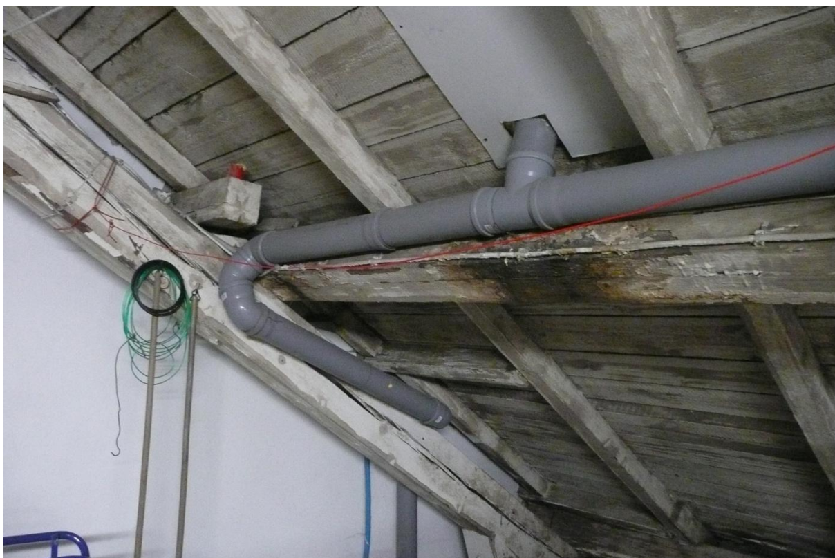
FOT.4 Widoczne pęknięcia elementów ram ( występujących co 4 m) oraz ugięcia krokwi dachowych
