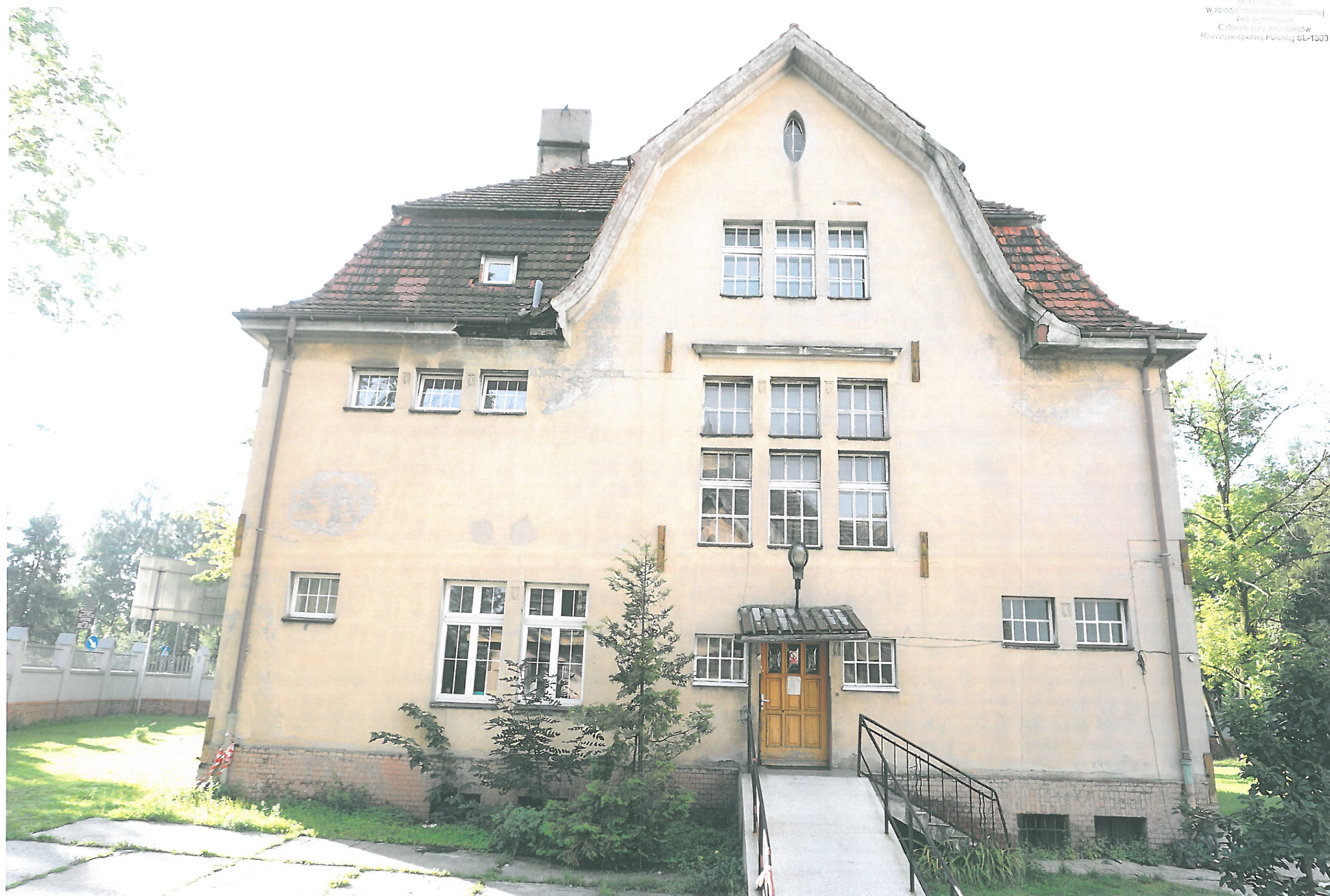
ELEWACJA PÓŁNOCNA - fotoinventaryzacja
