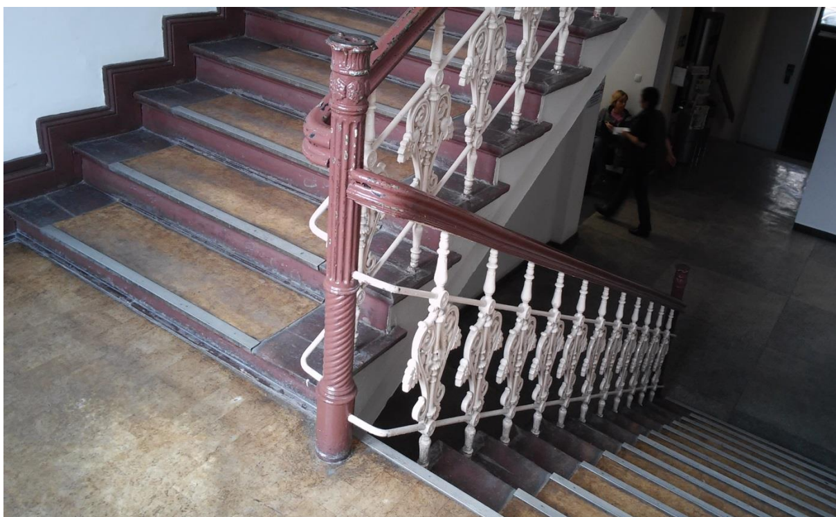
KLATKA SCHODOWA K1
