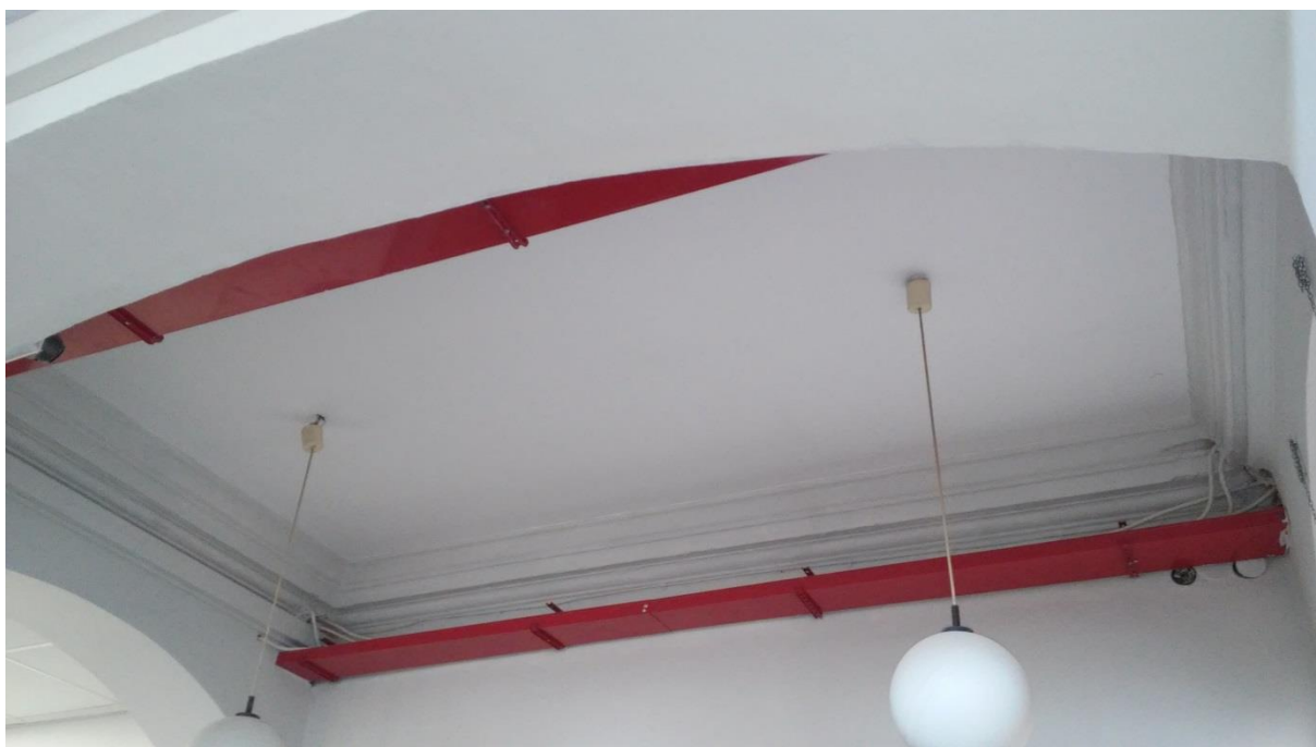
STROP NA KORYTARZU
