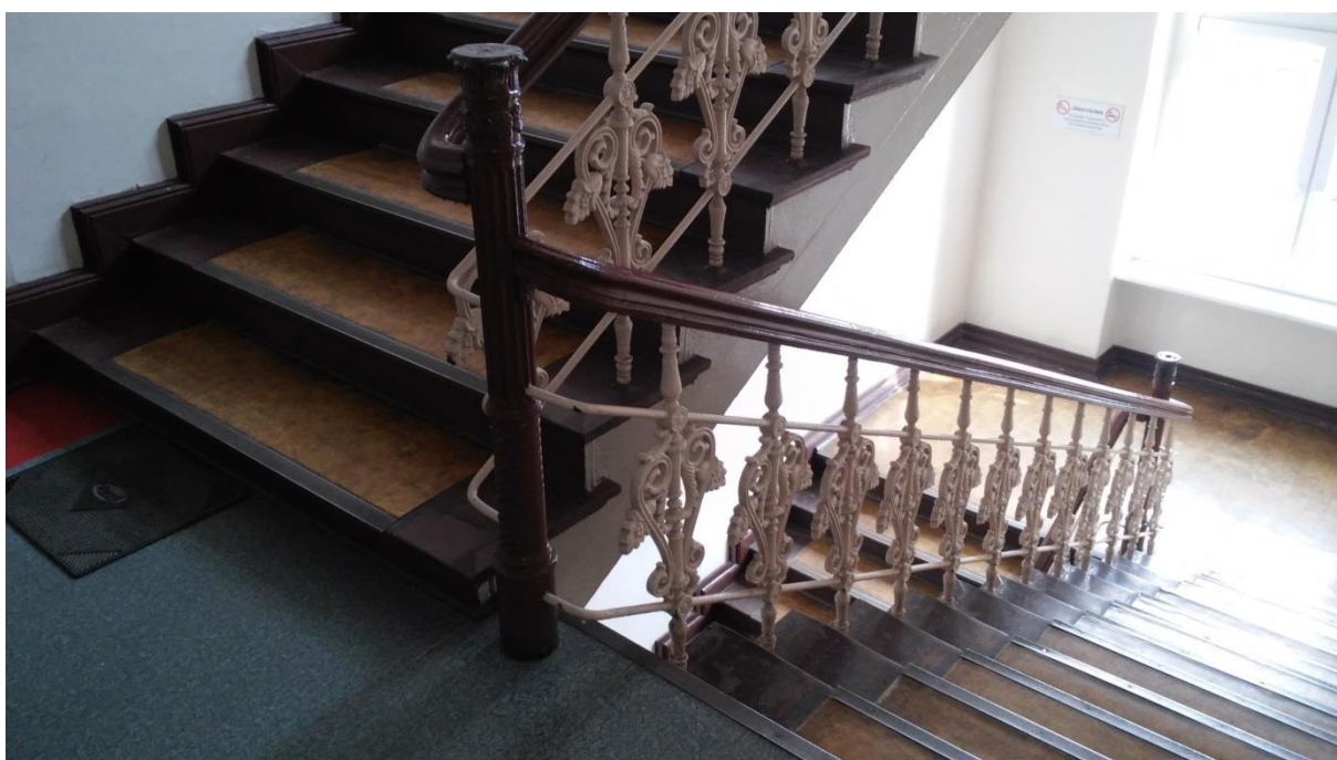
KLATKA SCHODOWA K1
