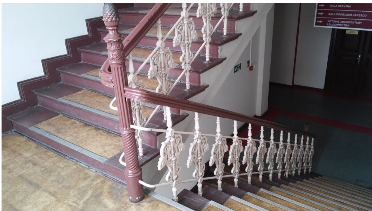
KLATKA SCHODOWA K1
