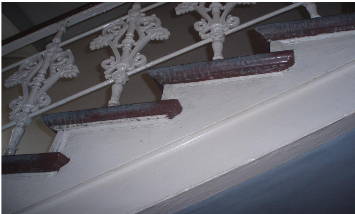
BELKI STALOWE KONSTRUKCJI SCHODÓW I DREWNIANE STOPNICE
