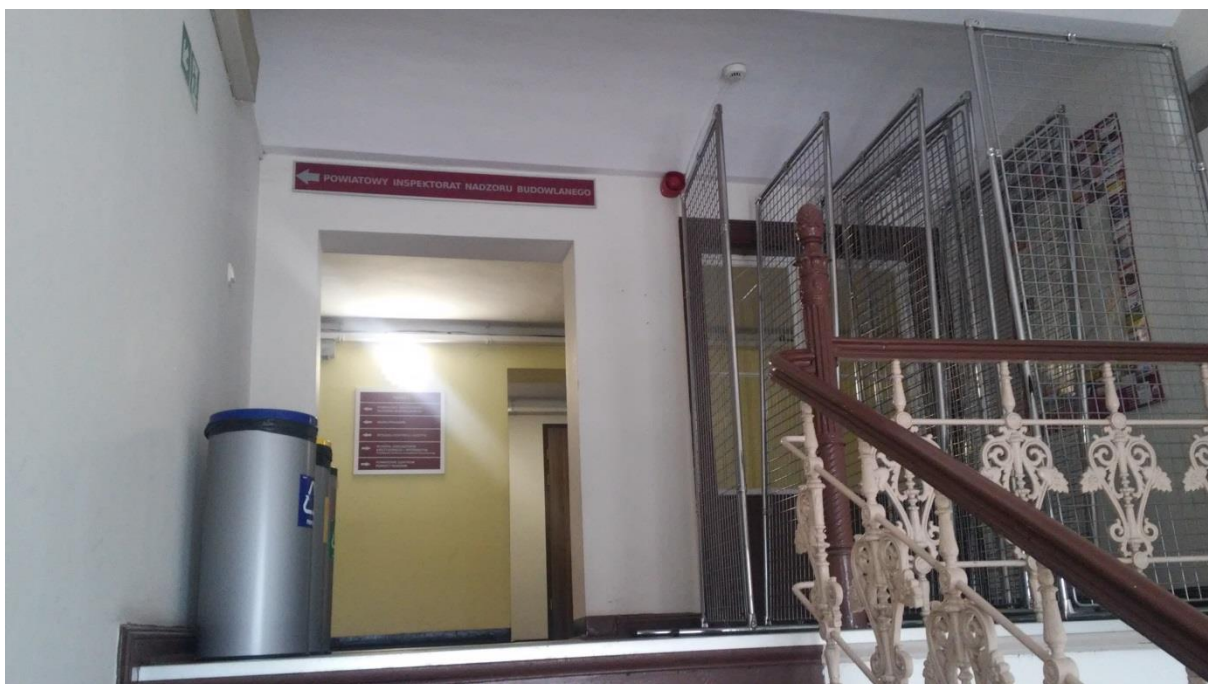
KLATKA SCHODOWA K1 – PODEST NA II PIĘTRZE
