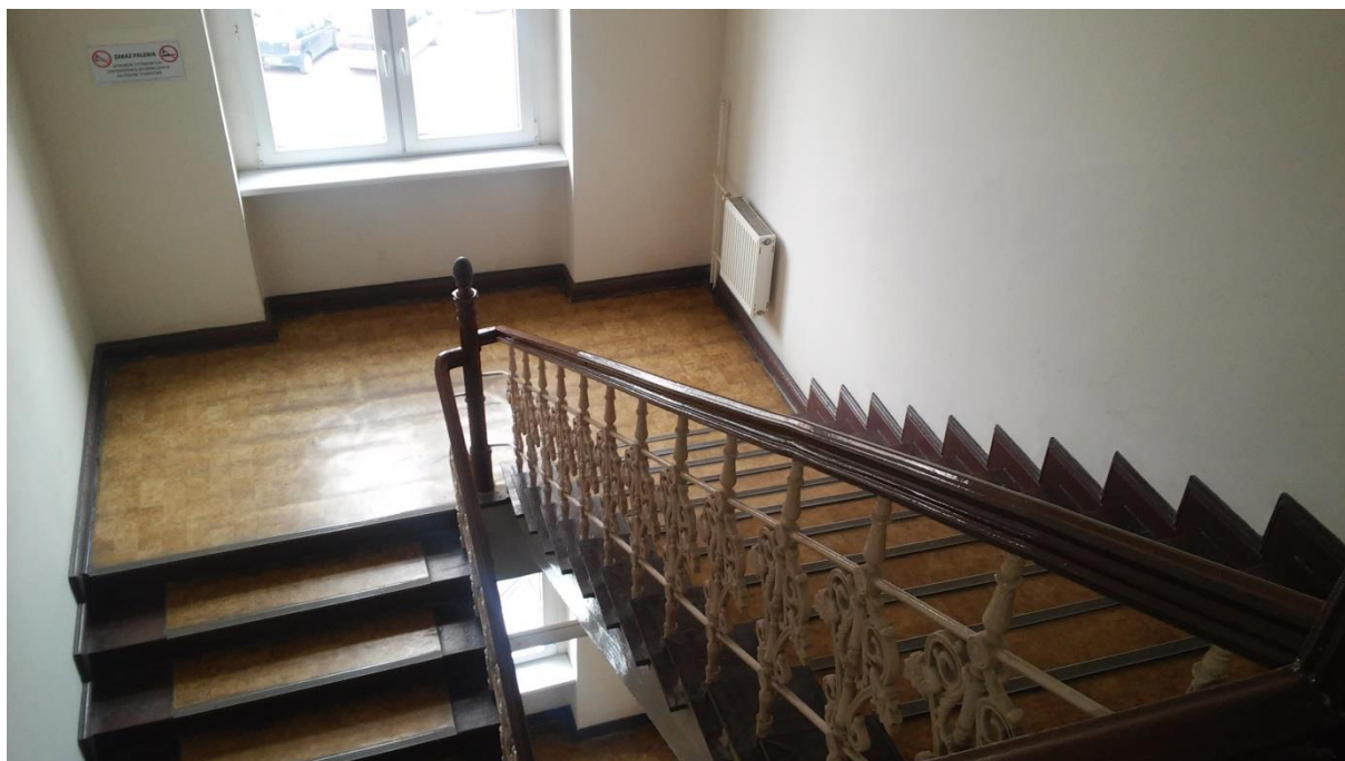
KLATKA SCHODOWA K1 – PODEST POMIĘDZY I PIĘTREM A II PIĘTREM
