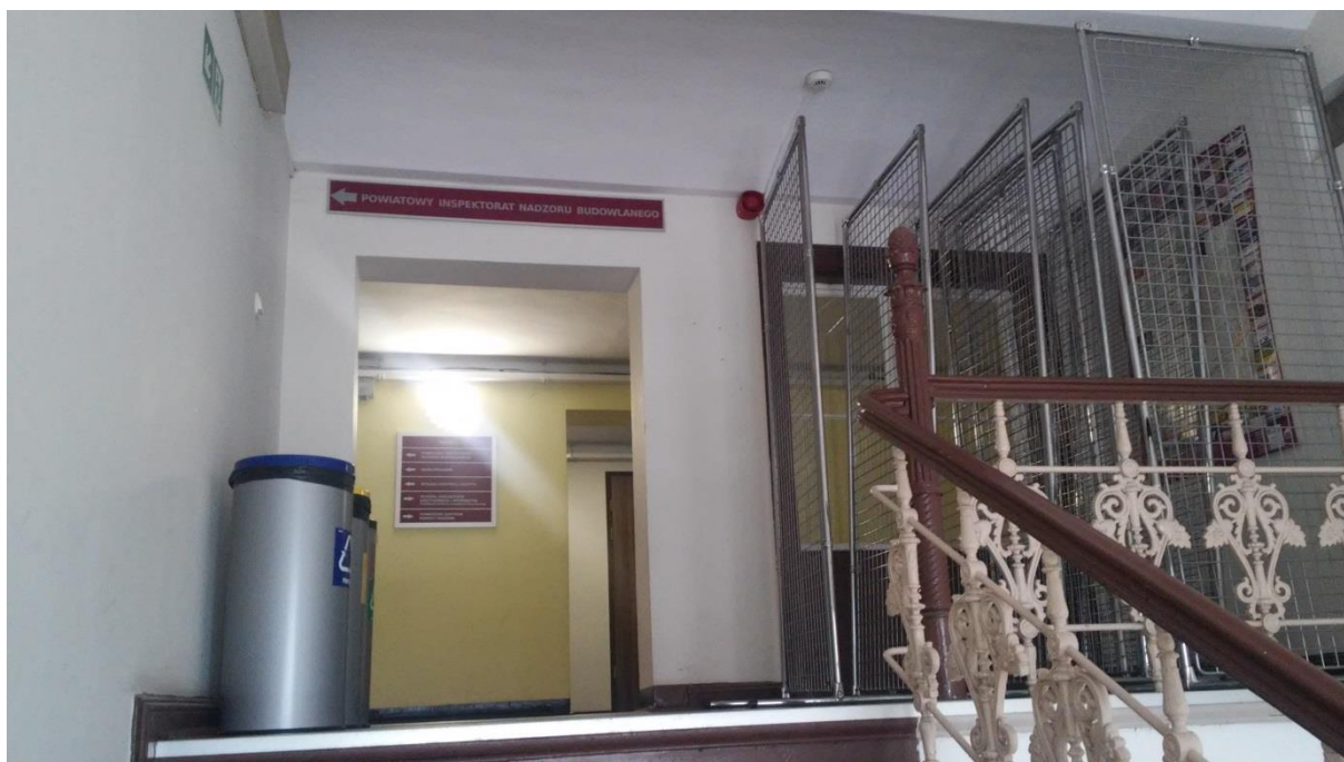
KLATKA SCHODOWA K1 – PODEST NA II PIĘTRZE
