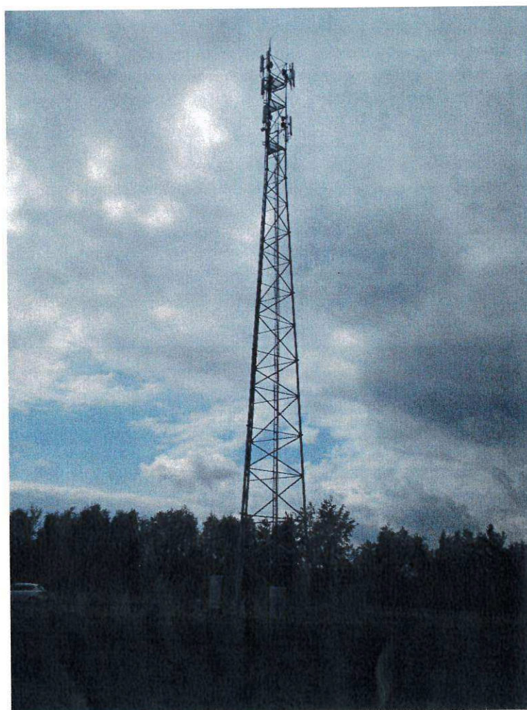
Zdjęcie 1 Badany obiekt
