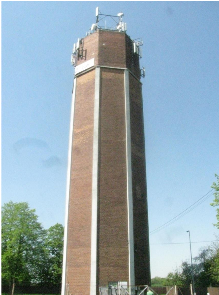
Zał. nr 1: Widok ogólny instalacji radiokomunikacyjnej.
