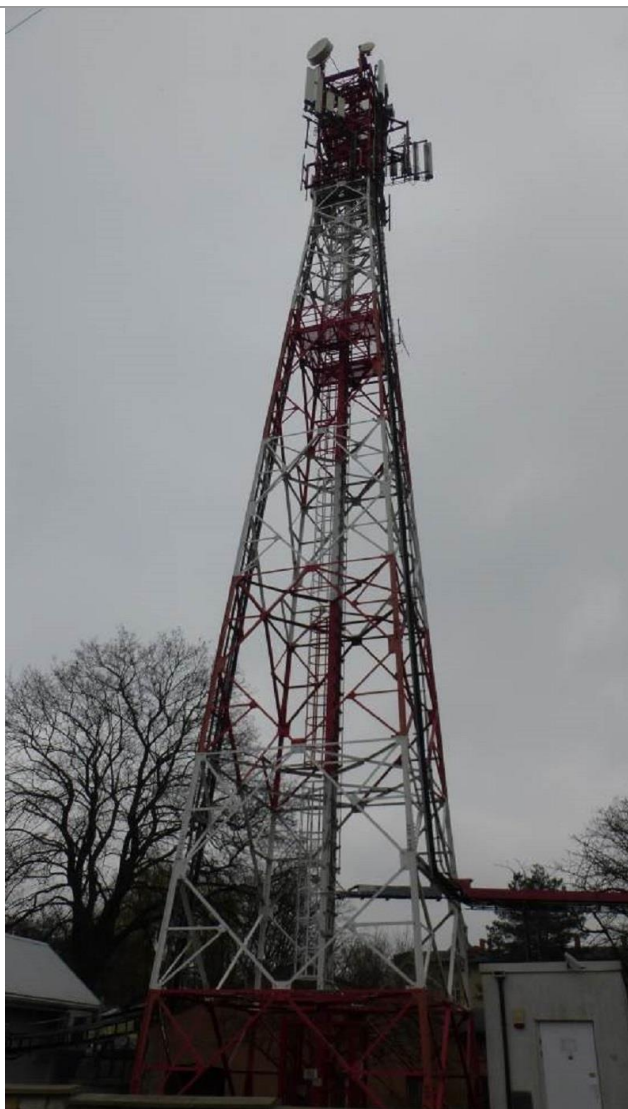
Fot. 1. SLR Pyskowice – widok obiektu
