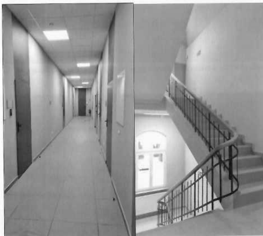
Fotografia 20 Widok korytarza i klatki schodowej po remoncie
