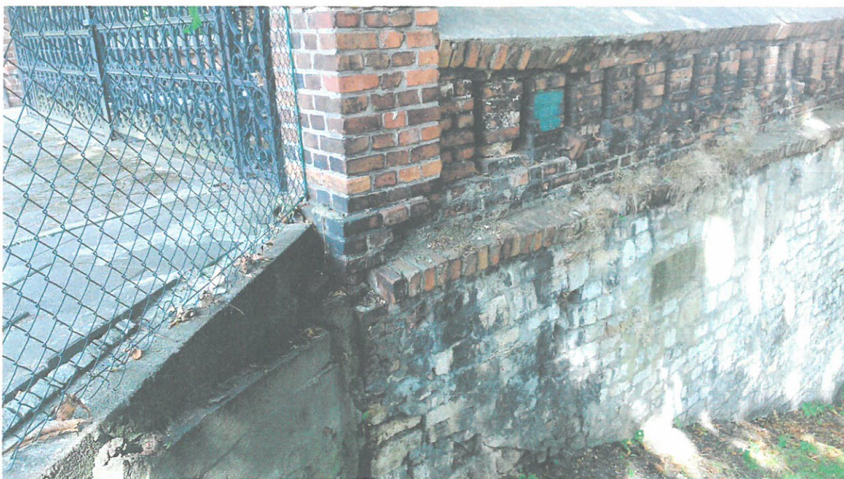
Fot.2 elementy balustrady i część dolna kamienna mostku
