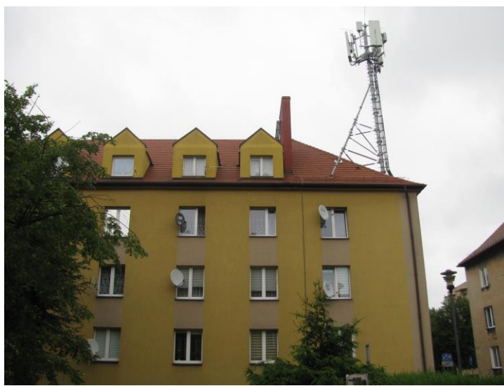
Zał. nr 1: Widok ogólny instalacji radiokomunikacyjnej.
