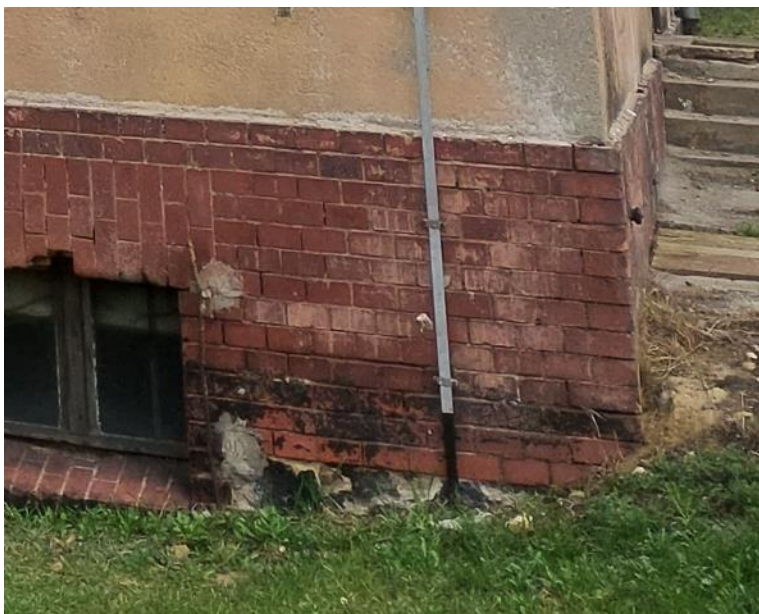
COKÓŁ Z KLINKIERU – UBYTKI DO UZUPEŁNIENIA, OCZYSZCZENIE CEGŁY
