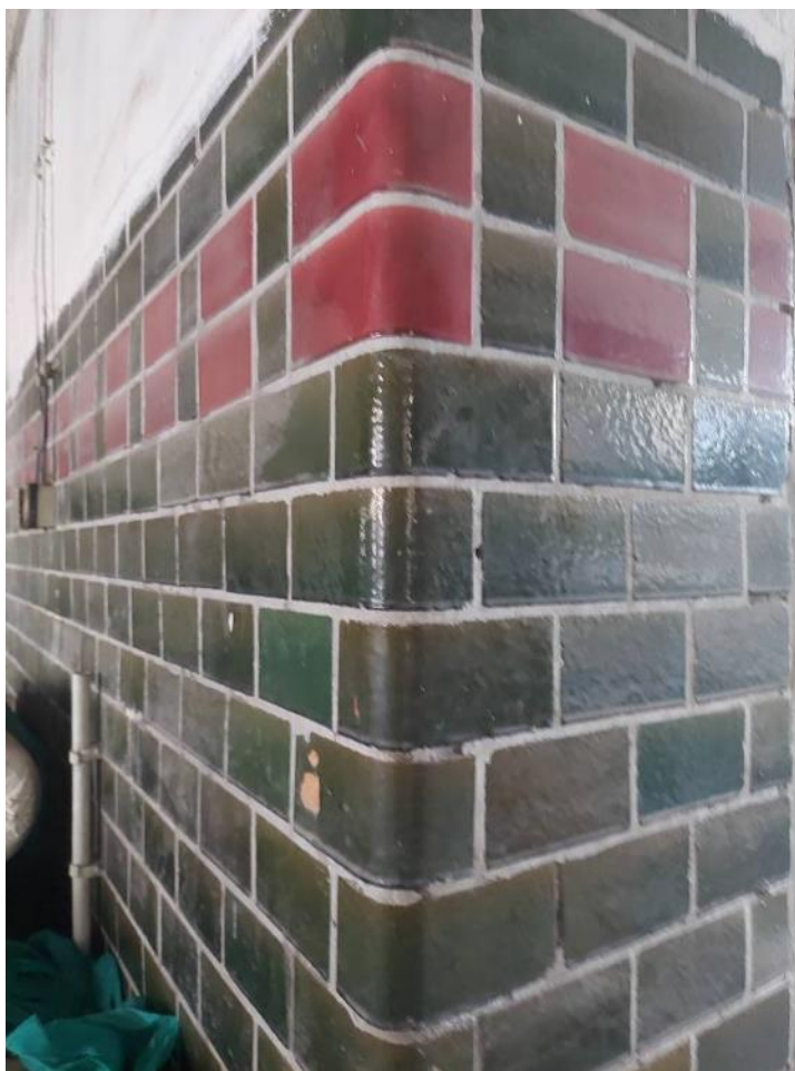
PŁYTKI ŚCIENNE WEWNĘTRZNE – RĘCZNA ROZBIÓRKA I ODZYSK CEGIEŁ NIEUSZKODZONYCH
